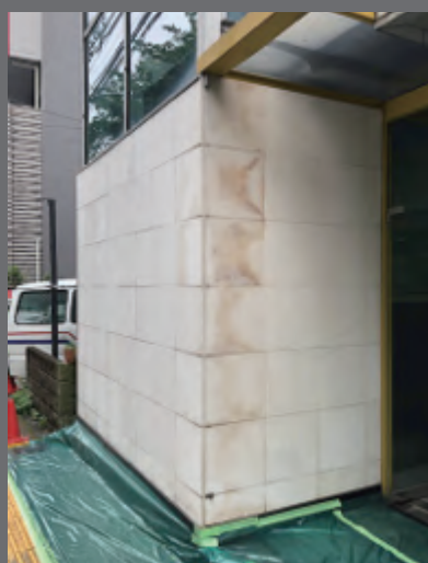
Before 既存壁 天然石 (ライムストーン)
